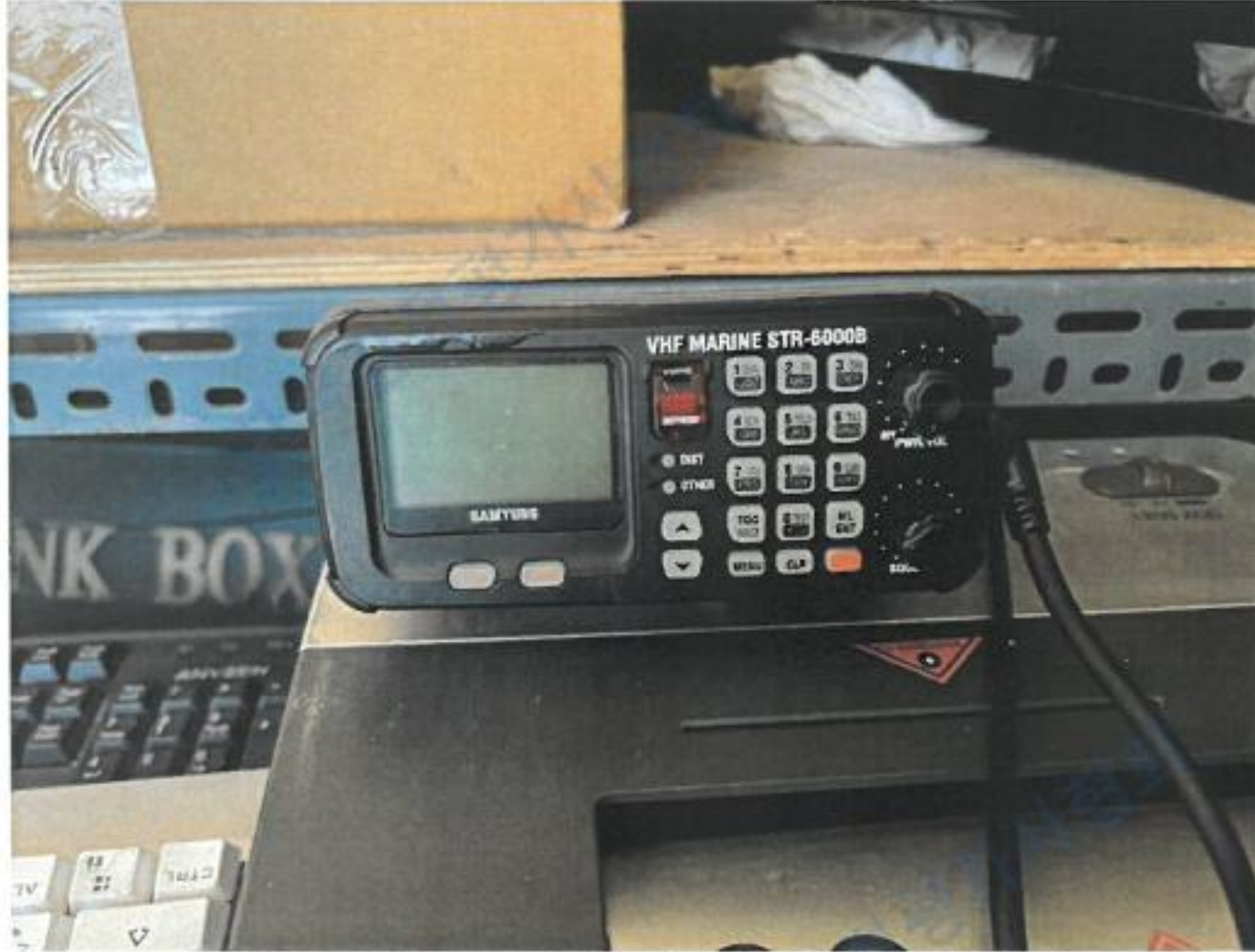
[ 의장품 11)(무전기) 전경 ]
