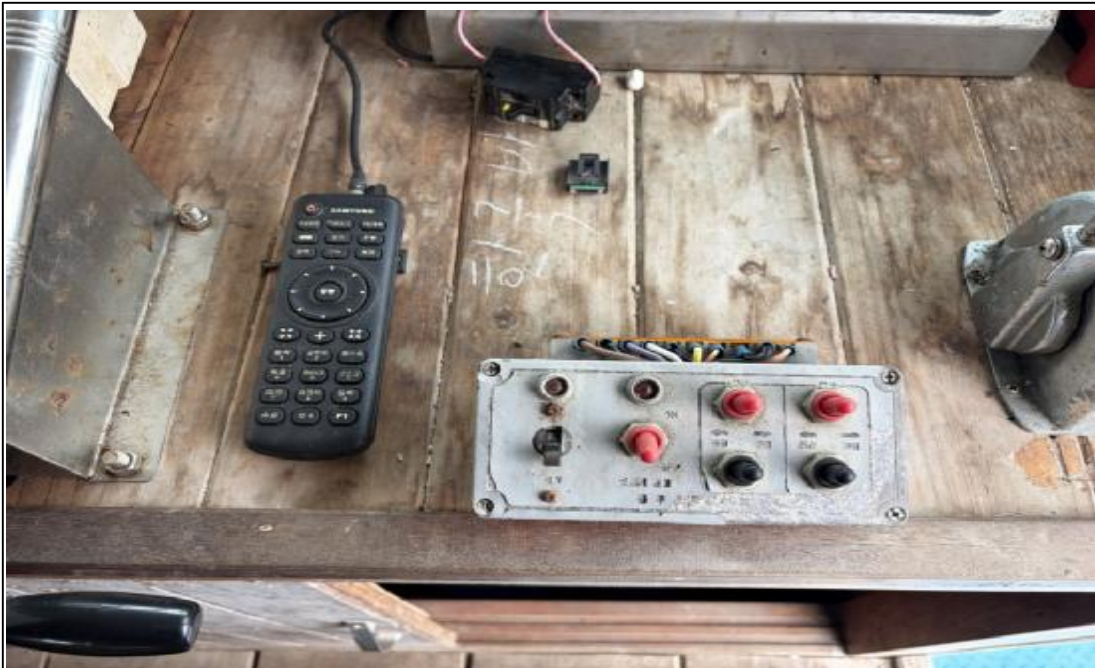
본건 선체부속 트러스터 컨트롤러
