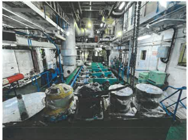
본건 전경 (기관실)
